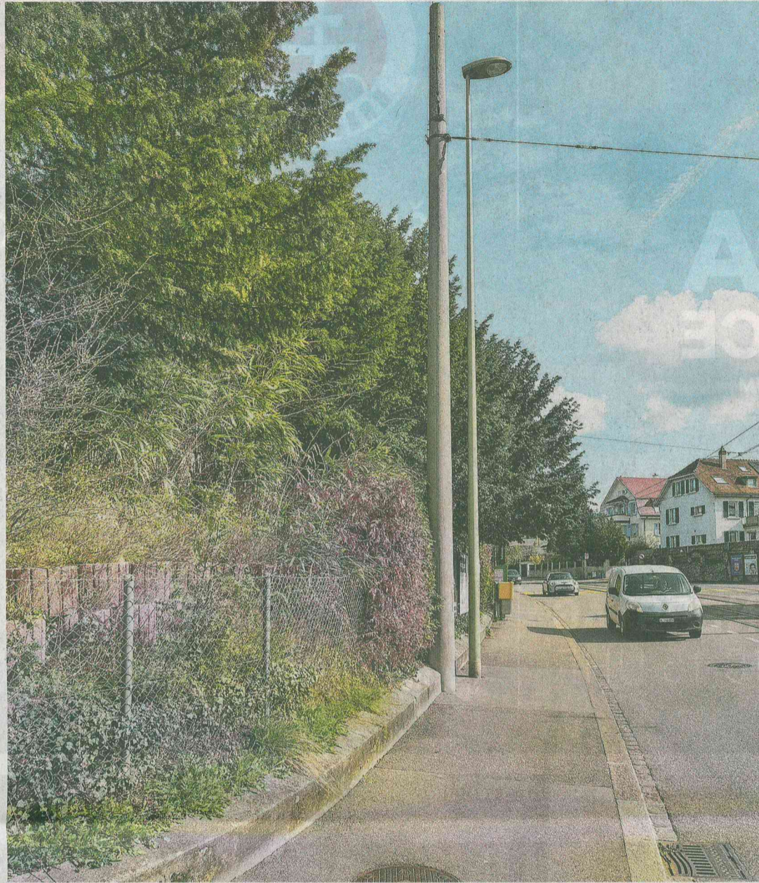
An dieser Böschung soll, geht es nach dem Kanton, die Strasse verbreitert werden. Bild: Kenneth Nars
