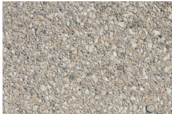
Referenz: Freilagerplatz, Münchenstein, Asphalt 16S mit farbigem Gubersplitt, Farblosbitumen, Oberfläche angeschliffen (Kleweg-Verfahren)
