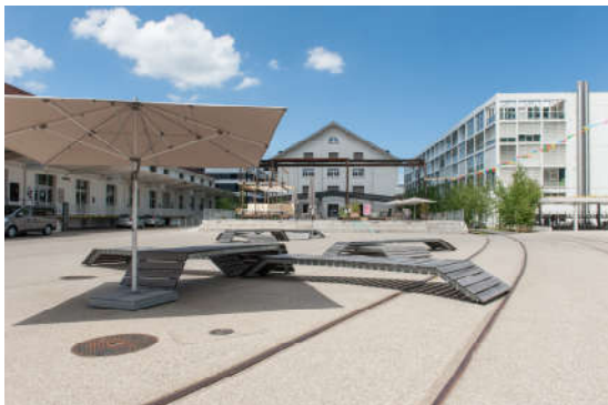
Referenz: Freilagerplatz, Münchenstein, Asphalt 16S mit farbigem Gubersplitt, Farblosbitumen, Oberfläche angeschliffen (Kleweg-Verfahren)
